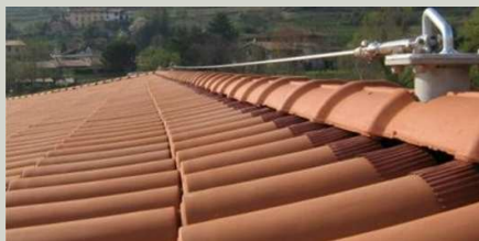
Esempio di dispositivo di sicurezza "linea vita"
