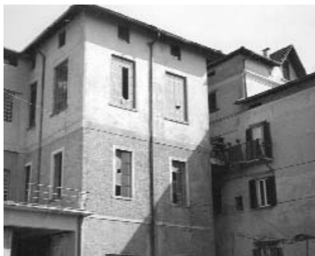
Figura 2. Stabilimento di Predore della Manifattura Colombo: porzione del corpo di fabbrica (lato opposto).
