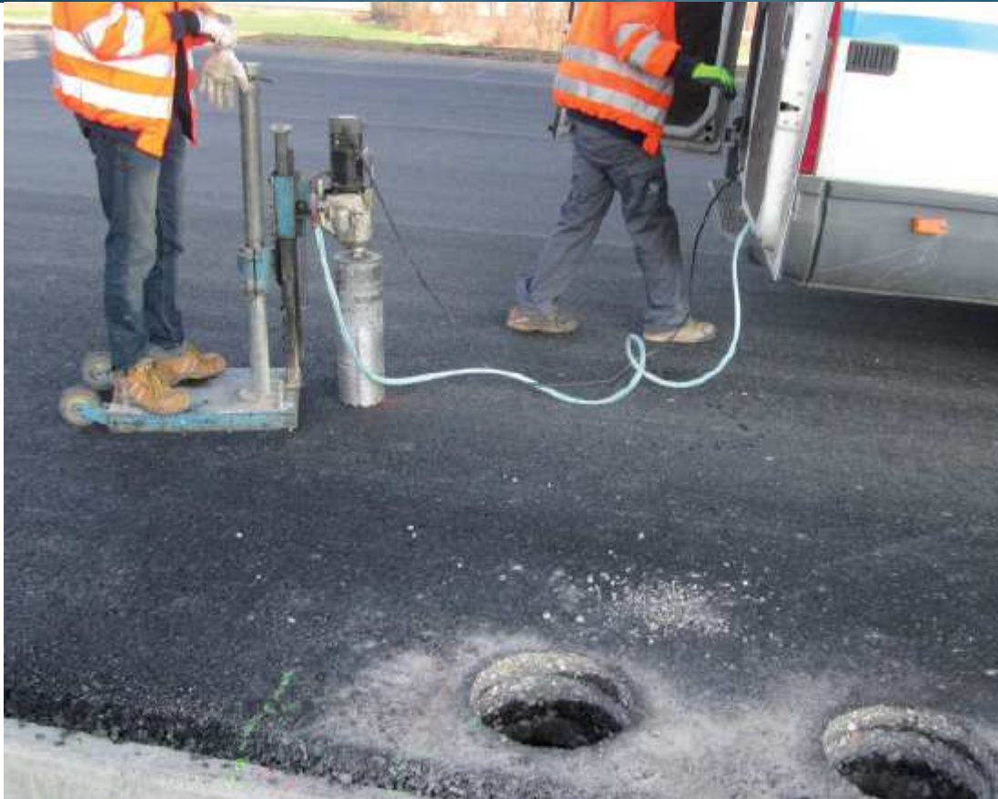
Carotaggio su pavimentazione
